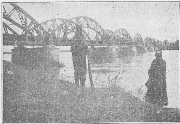
26. Ἡ σιδηροδρομικὴ γέφυρα τοῦ Ἀξιοῦ.
