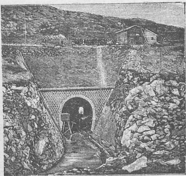
14. Ἡ σήραξ τῆς Καρδίτσης εἰς τὴν Κωπαίδα, διὰ τῆς ὁποίας τὰ ὕδατα διοχετεύονται εἰς τὴν λίμνην Παρχλίμνην καὶ ἀπὸ ἐκεῖ εἰς τὸν Εὐβοϊκὸν κόλπον
