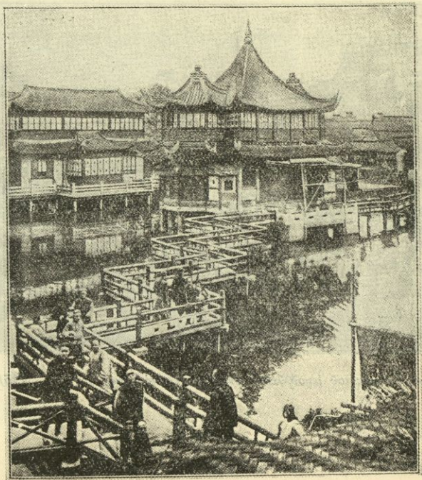
Γέφυρα ἐν Σινάνη ἐπὶ Κίνας (Σελ. 123)
