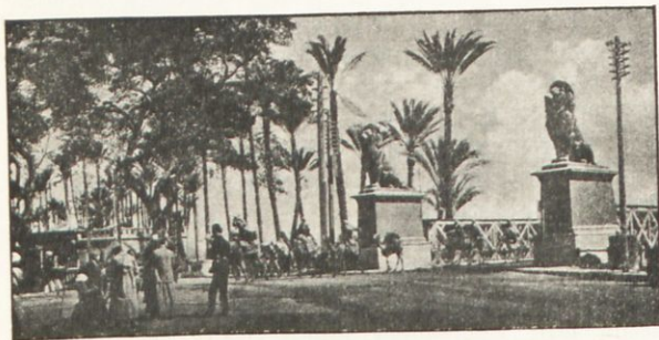
ΓΕΦΥΡΑ ΚΑΣΡ - ΕΛ - ΝΙΛ
