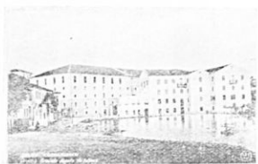
13. ΔΡΑΜΑ. Τὰ κτίρια ποὺ φαίνονται εἶναι αἱ μεγάλοι καπναποθήκαι καὶ τὰ ἐργοστάσια αὐσκευῆς τῶν καπνῶν ποὺ εἶναι πηγὴ πλοῦτου διὰ τὴν Α. Μακεδονίαν.
