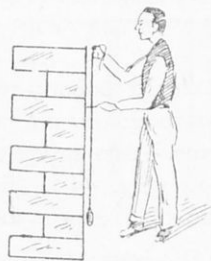
Σχ. 41. Μὲ τὸ νήμα τῆς στάθμης ἐλέγχουμε ἂν ὁ τοίχος εἶναι κατακόρυφος.
