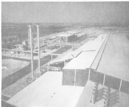
Σχ. 3.2θ. Ἐργοστάσιο Ζαχάρεως Ἐάνθης.
