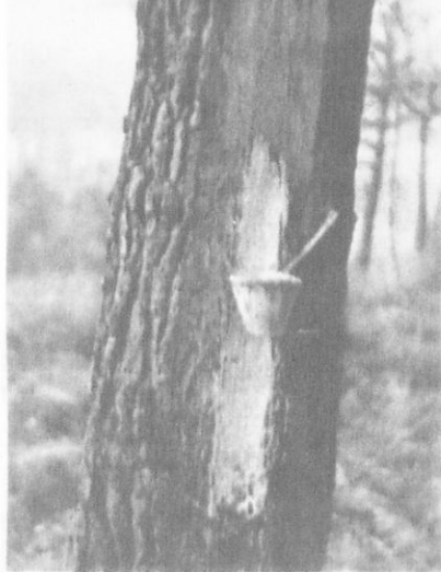
Εικ. 100. Πώς μαζεύεται τὸ ρετσίνι ἀπὸ τὸν κορμὸν τοῦ πεύκου.
