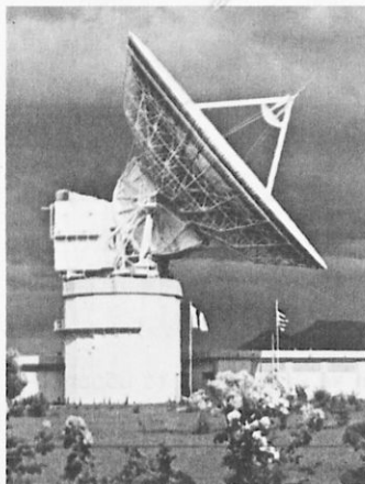
Σχ. 1. Δορυφορικός σταθμός εδάφους στις Θερμοπύλες. Ο σταθμός εξασφαλίζει ασύρματη τηλεπικοινωνία της Ελλάδας με άλλες χώρες μέσω τεχνητών δορυφόρων. Η σύνδεση με τους δορυφόρους και τις χώρες γίνεται με ηλεκτρομαγνητικά κύματα
