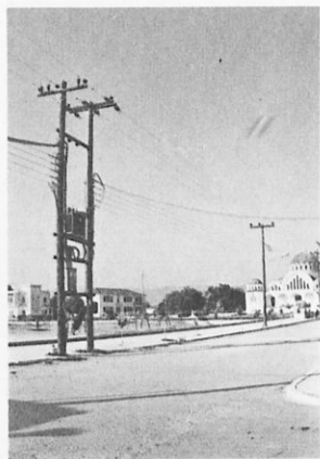
Σχ. 3. Μετασχηματιστής χαμηλής τάσεως. Μετατρέπει τα 15.000 V σε 220V και τροφοδοτεί το Στεφανοβίκειο Βόλου
