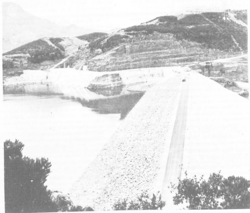
Φράγμα Κρεμαστῶν Ἀχελώου.
