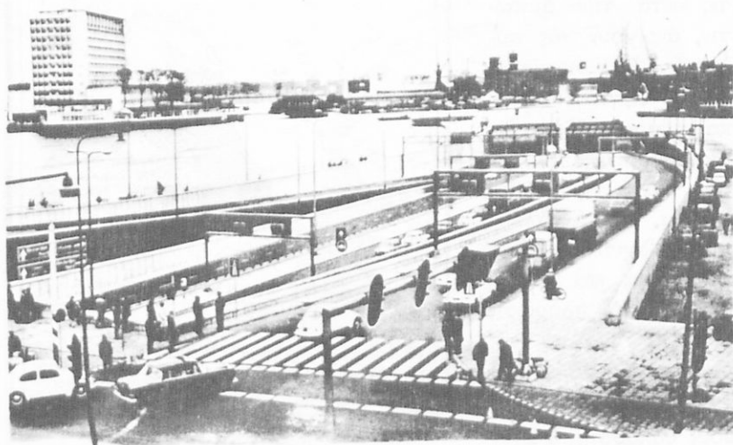
Εικόνα 18. Είσοδος σήραγκος κάτωθεν φράγματος
