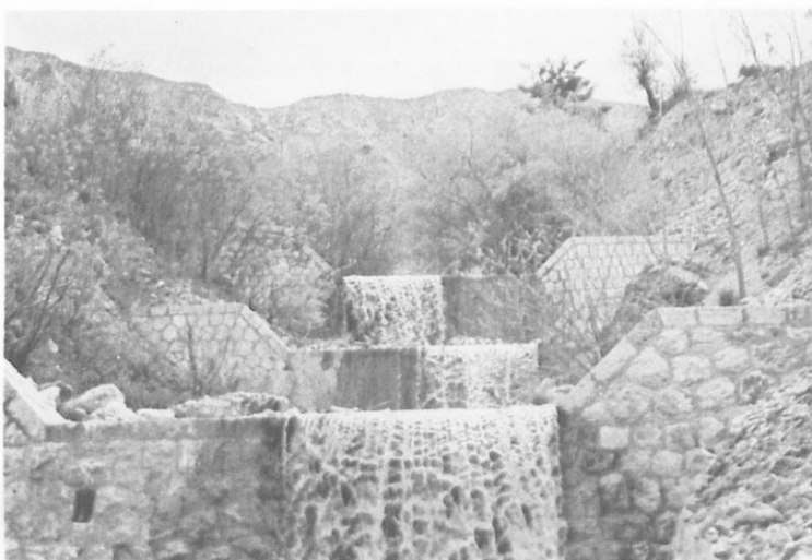
Εικ. 16.4. Διευθέτηση κοίτης χείμαρρου με μικρά φράγματα σε όρεινη περιοχή
