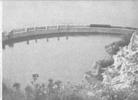
Είκ. 12.1. 'Η έλλειψη νερού για άρδευση του 'Αργολικού κάμπου οδήγησε στη δέσμευση των ύποθαλάσσιων πηγών του Κυβερίου 'Αργολίδας, με την κατασκευή φράγματος μέσα στη θάλασσα
