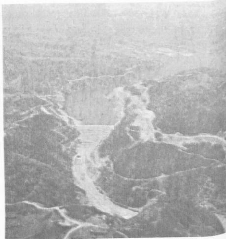
Εικ. 18.3. Τό φράγμα και ή τεχνητή λίμνη στό Πολύφυτο Κοζάνης
