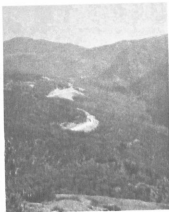
Εικ. 20.1. Δρόμος σε όρεινη περιοχή. 'Η χάραξη δρόμων σε πλαγιές προϋποθέτει σοβαρή μελέτη, για να μη δημιουργηθούν προβλήματα (κατολισθήσεις κ.ά.)
