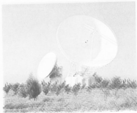
Εικ. 20.7. 'Ο δορυφορικός σταθμός έδαφους του Ο.Τ.Ε. στις Θερμοπύλες.
