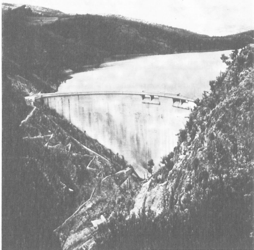
Τὸ φράγμα Ταυρωποῦ (ΔΕΗ)
