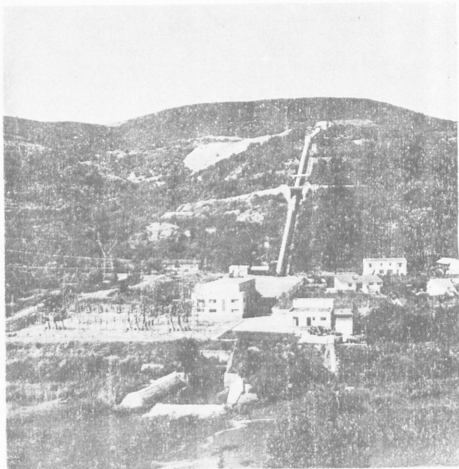
Ειχ. 157. 'Ο ύδροηλεκτρικός σταθμός "Άγρια ( πλησίον τῆς "Εδέσσης )
