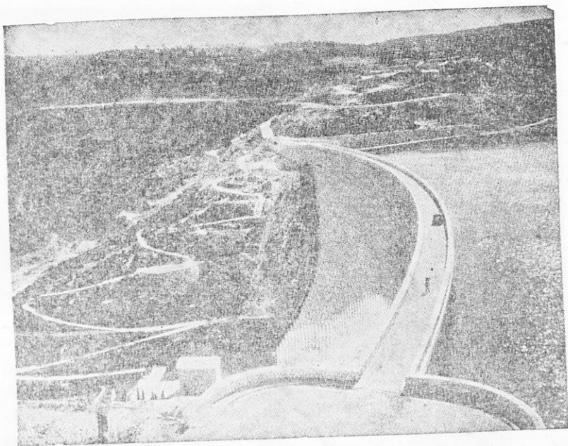
30. Τὸ φράγμα τῆς λίμνης τοῦ Μαραθῶνος. Ἀπὸ ἐδῶ τὰ νερά διοχετεύονται μὲ ὑπόγειον σήραγγα εἰς Ἀθήνας καὶ Πειραιᾶ.
