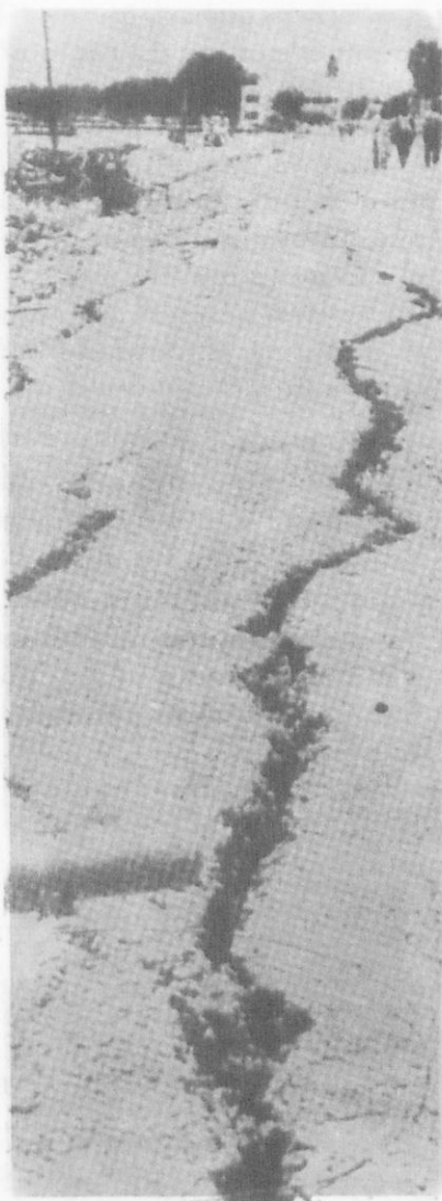
108. Σεισμογενὴς ρωγμὴ σχηματισθεῖσα εἰς τὸ ἔδαφος τῆς πόλεως Ζακύνθου κατὰ τοὺς σεισμοὺς 9 ἕως 12 Αὐγούστου 1953.
