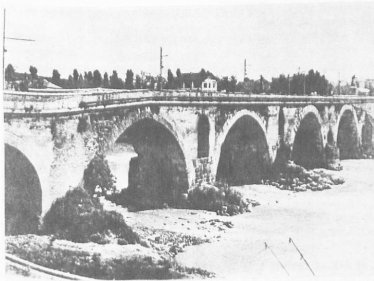
**Η Μουλβία γέφυρα στή Ρώμη, με ήμικυκλικά τόξα πού ανέζανυν σέ υψος και στηρίζονται σέ βάθρα ογκώδη. Χτίστηκε με πορόλιθο και άσβεστόλιθο χωρίς κονίαμα, τό 109 π.Χ.**
