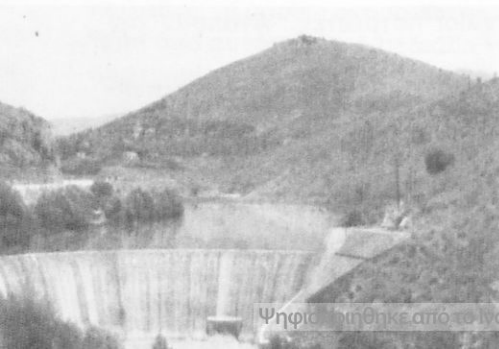
Λούρος - τὸ φράγμα
