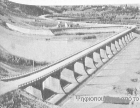
Γέφυρα γιὰ αὐτοκίνητα
