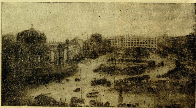
37. Τόκιο. Ἀποψὶς κεντρικοῦ σιδηροδρομικοῦ σταθμοῦ.
