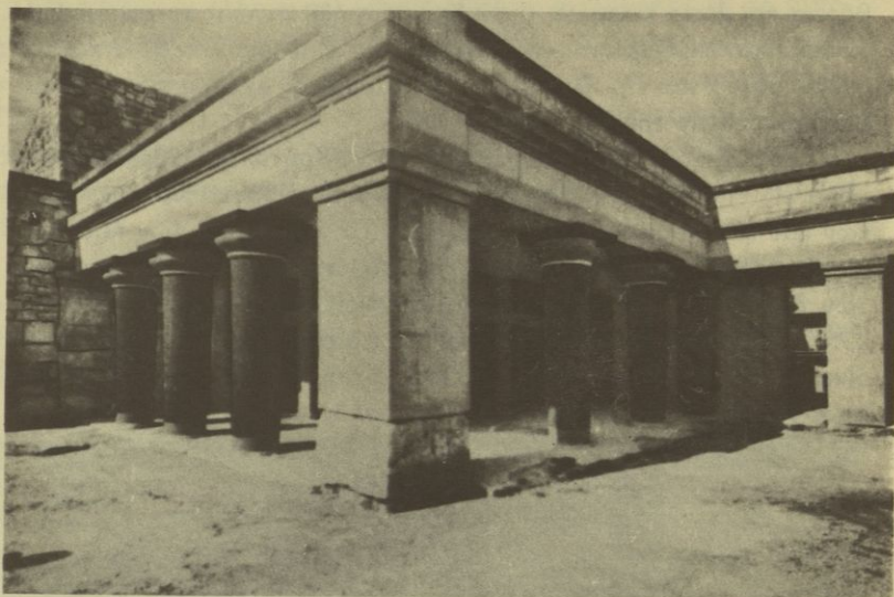
Ἐνάκτορον Κνωσοῦ. Ἀνατολική πτέρυξ. Ὁ κορμὸς τῶν κιόνων λεπτύνεται πρὸς τὰ κάτω.
