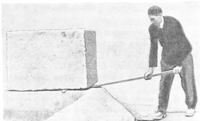
Σχ. 132. Ὁ μοχλὸς χρησιμεύει γιὰ νὰ μετακινήσωμεν ἕνα βαρὺ σῶμα.
