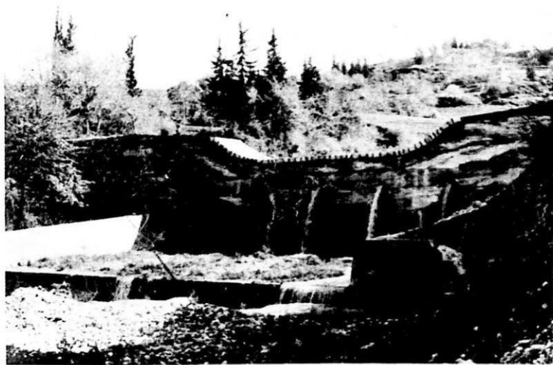
Διά νὰ ἀποφεύγωνται αἱ καταστροφαὶ αἱ ὅποῖαι προξενοῦνται ἀπὸ τοὺς χειμάρρους κατασκευάζονται μικρὰ φράγματα εἰς τὰς δρεινὰς κοίτας τῶν.
