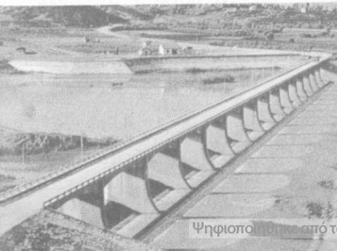
Γέφυρα γιὰ αὐτοκίνητα
