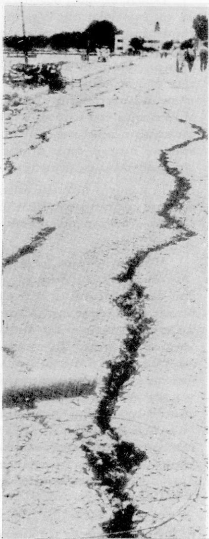
108. Σεισμογενὴς ρωγμὴ σχηματι- σθεῖσα εἰς τὸ ἔδαφος τῆς πόλεως Ζα- κύνθου κατὰ τοὺς σεισμοὺς 9 ἕως 12 Αὐγούστου 1953.
