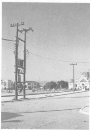
Σχ. 3. Μετασχηματιστής χαμηλής τάσεως. Μετατρέπει τά 15.000 V σε 220 V και τροφοδοτεί τό Στεφανοβίκειο Βόλου
