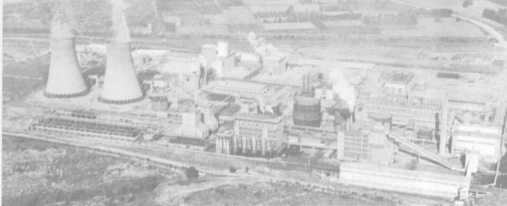
Πτολεμαΐδα - εργοστάσιο άζώτου
