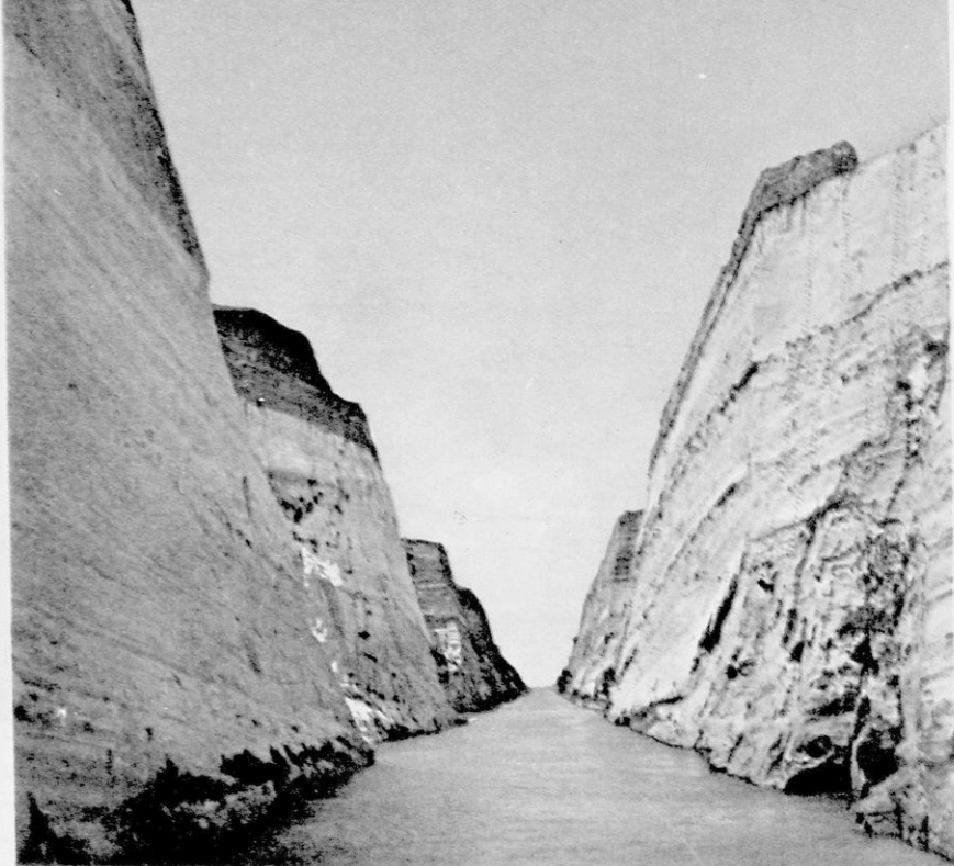
46. Τὸ Δ. ἄκρον τῆς διώρυγος τοῦ Ἴσθμοῦ τῆς Κορίνθου. Εἰς τὴν ἀριστερὰν πλευρὰν εἶναι ἐμφανεῖς αἱ μεταπτώσεις, αἱ ὁποῖαι ἐδημιούργησαν τὴν κλιμακοειδῆ καταβύθισιν.
