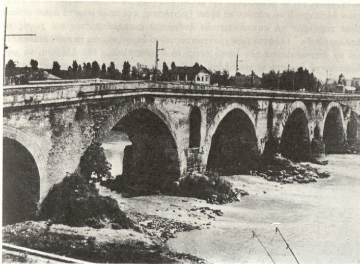
Ἡ Μουλθία γέφυρα στή Ρώμη, μέ ἡμικυκλικά τόξα πού ἀβξάνουν σέ ὕψος καί στηρίζονται σέ βάθρα δγκώδη. Χτίστηκε μέ πρωτόλιθο καί ἀσβεστόλιθο χωρίς κονίαμα, τό 109 π.Χ.
