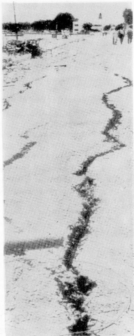
108. Σεισμογενὴς ρωγμὴ σχηματισθεῖσα εἰς τὸ ἔδαφος τῆς πόλεως Ζακύνθου κατὰ τοὺς σεισμούς 9 ἕως 12 Αὐγούστου 1953.
