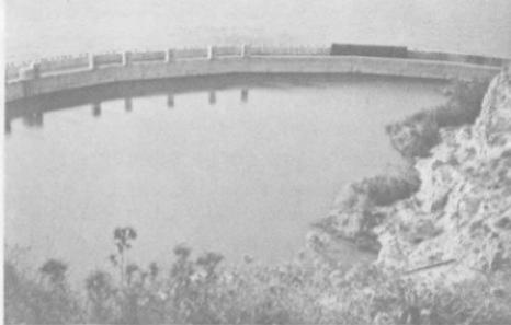
Εἰκ. 12.1. Η ελλειψη νερού γιά άρδευση του Αργολικού κάμπου δόήγησε στή δέσμευση των ύποθαλάσσιων πηγών του Κυθερίου Αργολίδας, με τήν κατασκευή φράγματος μέσα στή θάλασσα
