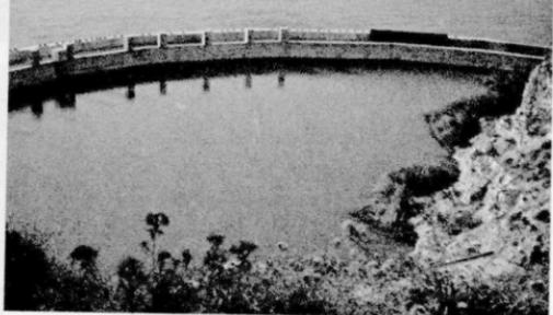
Εἰκ. 12.1. Η έλειψη νερού γιά όρδευση του Αργολικού κάμπου όδηγησε στή δέσμευση των υποθαλάσσιων πηγών του Κυθερίου Αργολίδας, με τήν κατασκευή φράγματος μέσα στή θάλασσα
