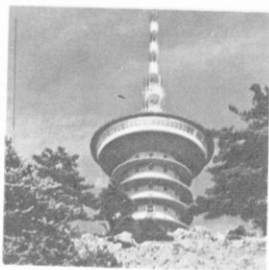
Σχ. 2. Ασύρματη τηλεπικοινωνία (Σταθμός μικροκυμάτων Γερανείων μέ κεραία τηλεοράσεως)
