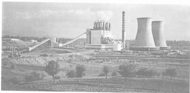
Σχ. 1. Άτμοηλεκτρικός Σταθμός Μεγαλοπόλεως (250 MW)
