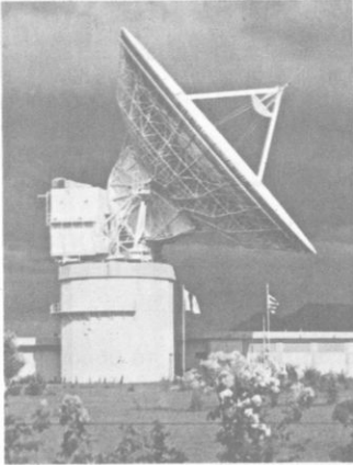
Σχ. 1. Δορυφορικός σταθμός εδάφους στίς Θερμοπύλες. Ο σταθμός εξασφαλίζει ασύρματη τηλεπικοινωνία της Ελλάδας με άλλες χώρες μέσω τεχνητών δορυφόρων. Η σύνδεση με τούς δορυφόρους και τίς χώρες γίνεται με ηλεκτρομαγνητικά κύματα
