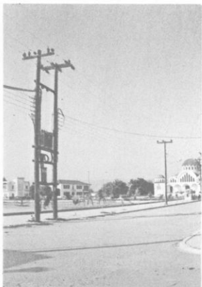
Σχ. 3. Μετασχηματιστής χαμηλής τάσεως. Μετατρέπει τά 15.000 V σε 220 V και τροφοδοτεί το Στεφανοβίκειο Βόλου
