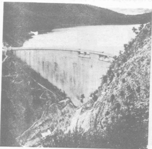
Το τοξωτό φράγμα του υδροηλεκτρικού σταθμού του Ταυρωπού
