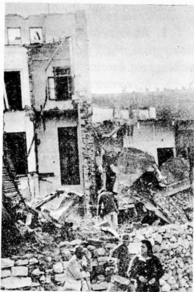
Κατεστραμμένα οἰκία ἐκ σεισμῶν.
