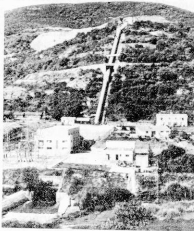
Γενικὴ ἀποψὶς τοῦ Ὑδροηλεκτρικοῦ Σταθμοῦ Ἄγρα, μὲ τὸν ἀγωγὸν πτώσεως, μήκους 355 μέτρων.
