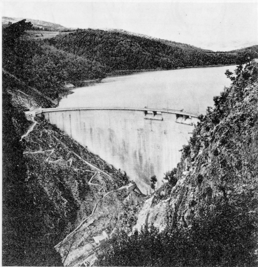
Τὸ φράγμα Ταυρωποῦ (ΔΕΗ)
