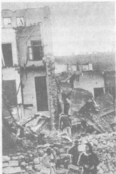
Κατεστραμμένα οἰκία ἐκ σεισμῶν.
