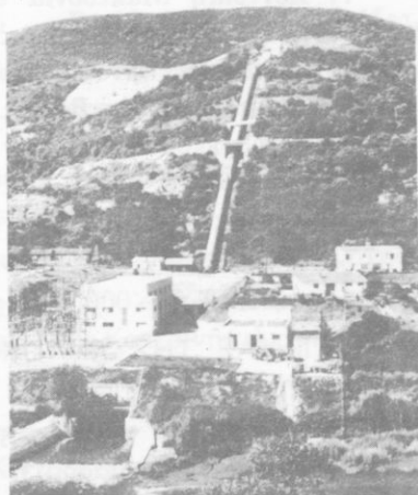
Γενικὴ ἀποψὶς τοῦ Ὑδροηλεκτρικοῦ Σταθμοῦ Ἄγρα, μὲ τὸν ἀγωγὸν πτώσεως, μήκους 355 μέτρων.
