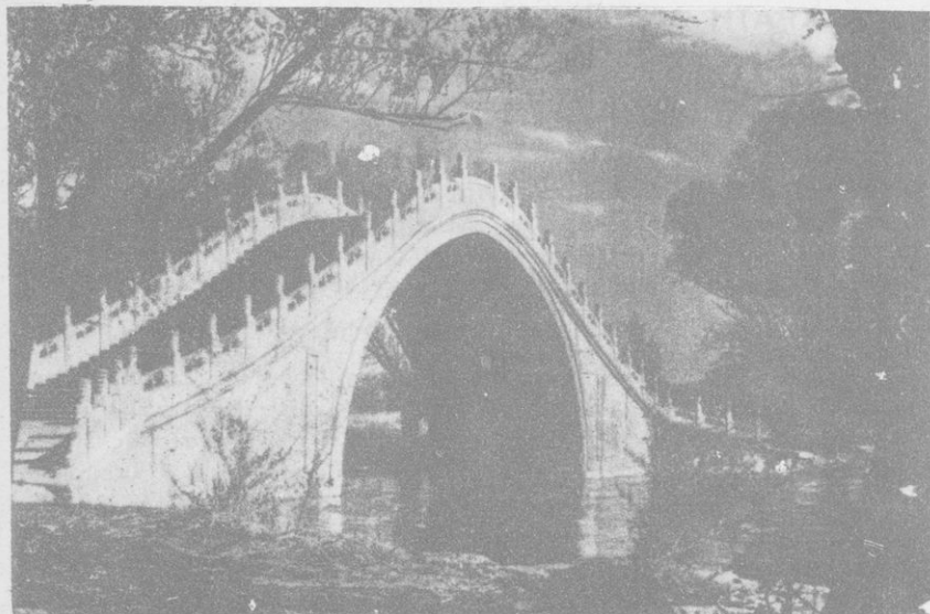
Εικ. 23. Χαρακτηριστική γέφυρα της Κίνας.
