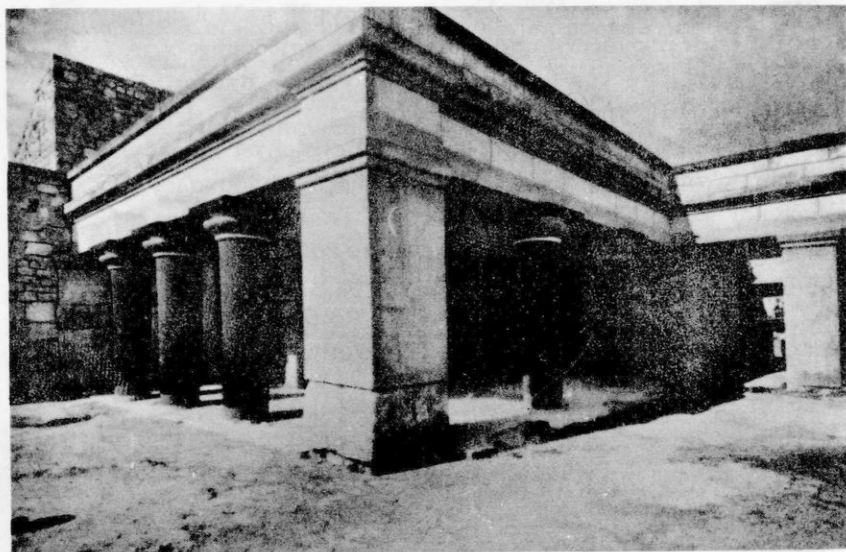
Ἀνάκτορον Κνωσοῦ. Ἀνατολική πτέρυξ. Ὁ κορμός τῶν κίωνων λεπτύνεται πρὸς τὰ κάτω.
