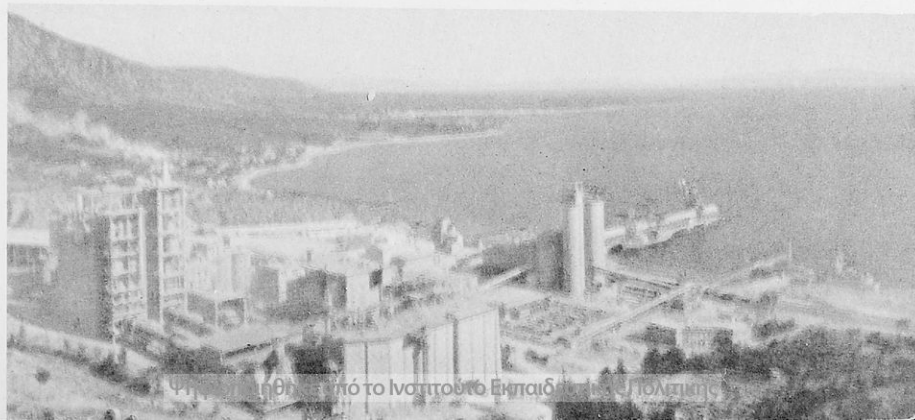
'Εργοστάσιο τσιμέντου στό Βόλο
