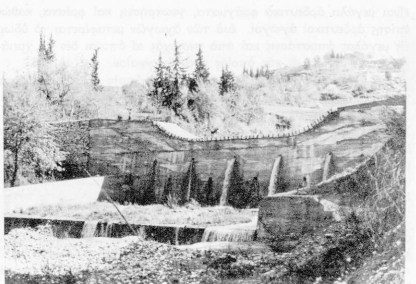
Διὰ νὰ ἀποφεύγωνται αἱ καταστροφαὶ αἱ ὅποιαι προξενοῦνται ἀπὸ τοὺς χειμάρρους κατασκευάζονται μικρὰ φράγματα εἰς τὰς δρεινὰς κοίτας των.
